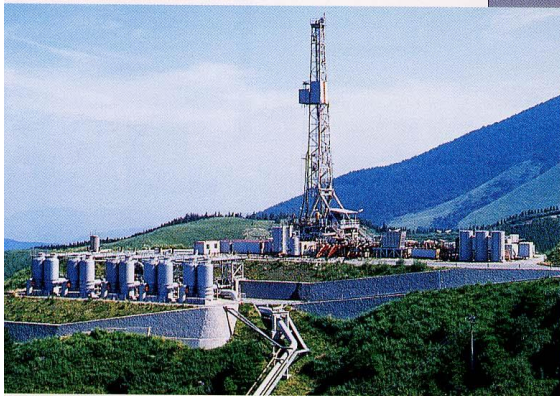
■蒸気井掘削状況
