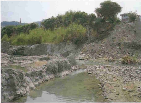
写真 1 逆断層の断面と河床の食い違い（大坑東部）
