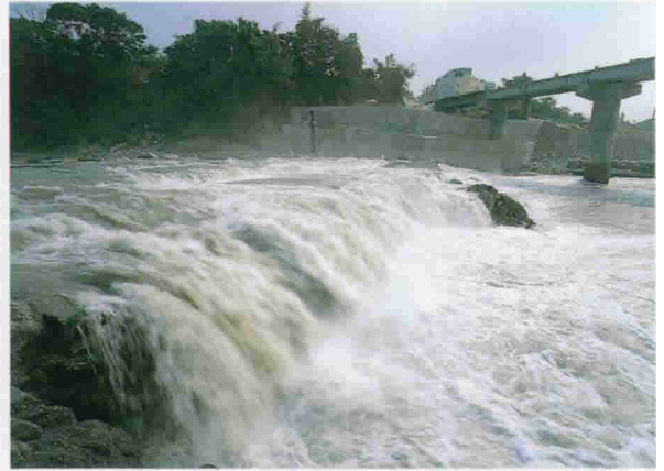
写真 2 地震断層によって大甲溪の河床にできた滝 .
