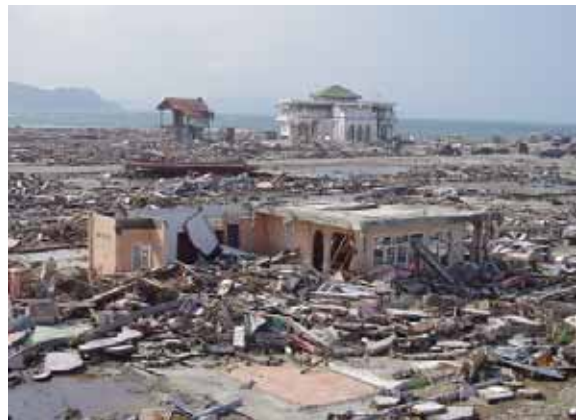
写真 4 バンダアチェの北海岸 (Ulee Lheue beach) 近くの被災状況。ほとんどの建物が破壊され、流失している。
