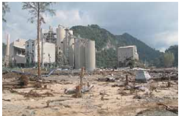
写真 6 ロックガ地区西海岸: 津波による被害を受けたセメント工場。
