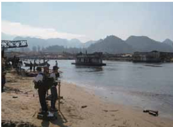
写真 7 ロックガ地区西海岸：津波で流失した橋の残された橋脚。
