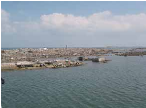
写真 3 バンダアチェの北海岸 (Ulee Lheue beach) 近くの被災状況。すべての建物が破壊され、流失している。
