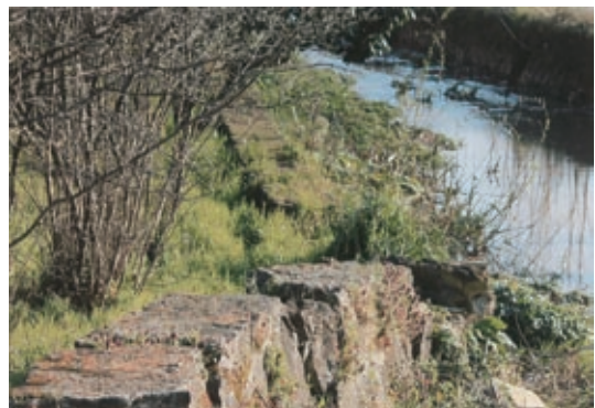
図 12 クラール (ギョルジュクの東) で見られる 横ずれ断層。 堤防が壊され、折れ曲がり、ずれている (写 真中央部)。
