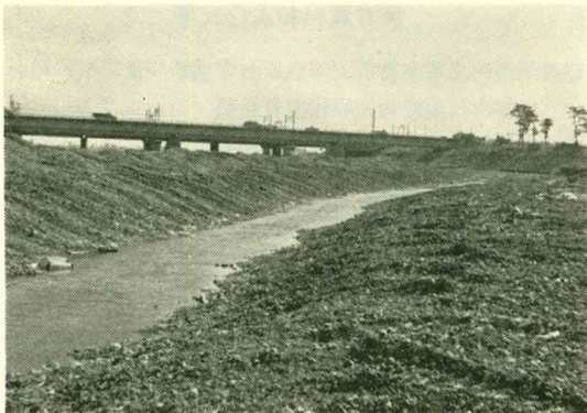
写真 4.1 仮開削による導水
